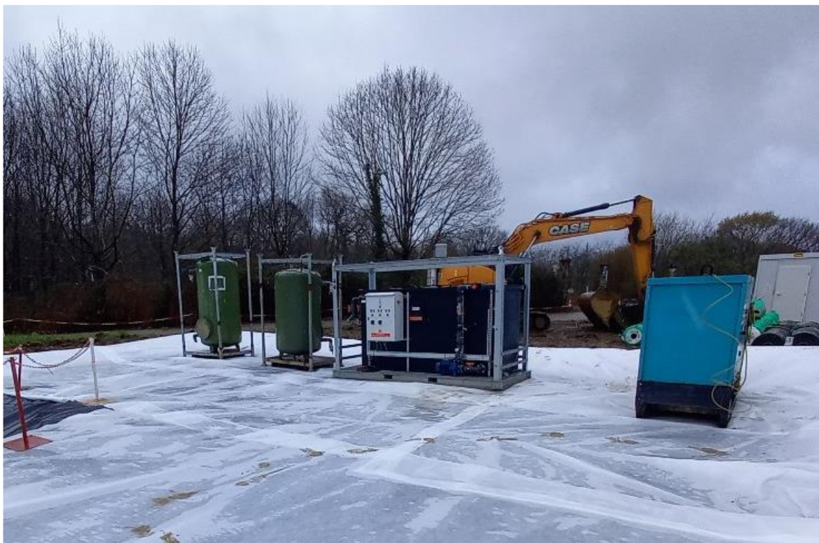
Figure 7 : Mise en place de l'UTE (Source : SECHE ECO SERVICE)
